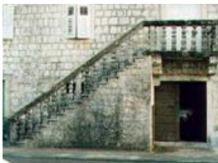
Kamena fasada sa stepeništem
